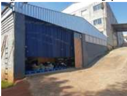
Figura 1: Vista Frontal do galpão
