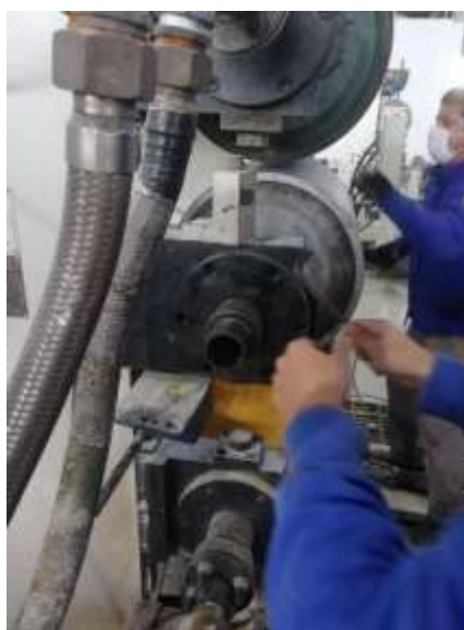
Figura 2 – Desmontagem dos mancais
