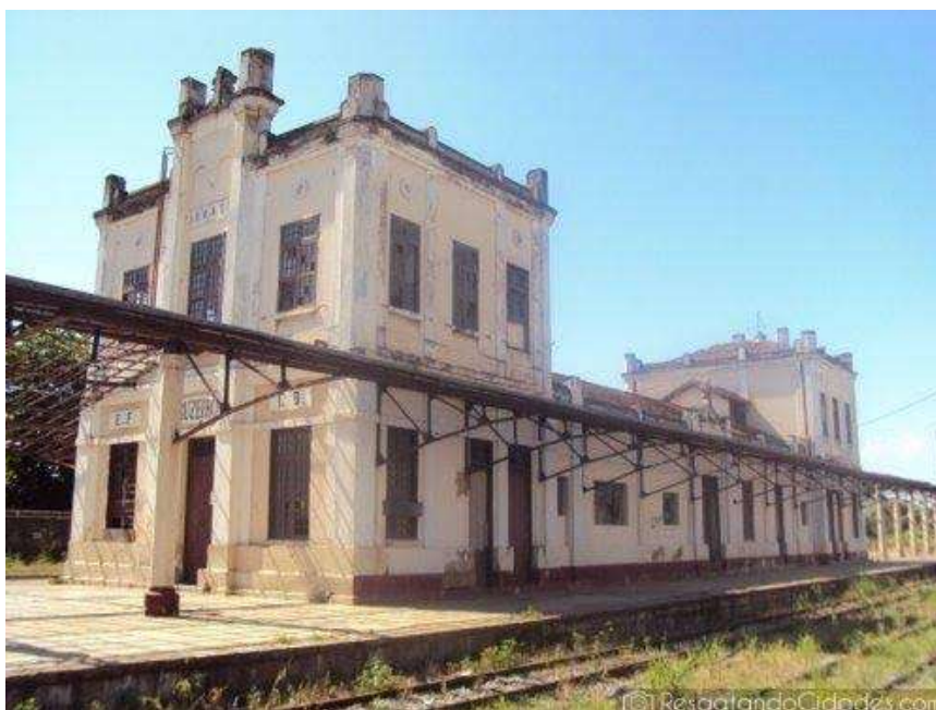
Figura 1: Estação Ferroviária de Cruzeiro -SP
